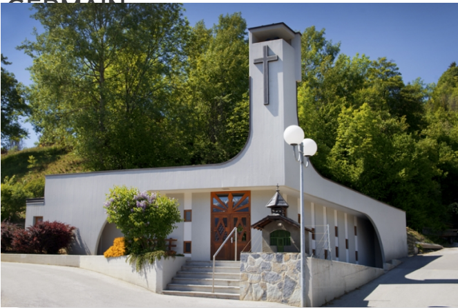
EGLISE PAROISSIALE DE ST-GERMAIN
